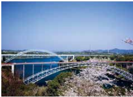
針尾電波塔と西海橋
